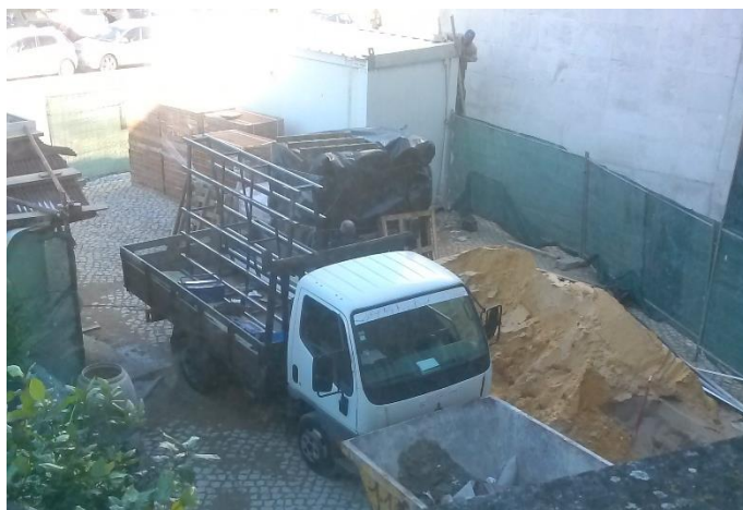
Figura 29 Estaleiro da obra
