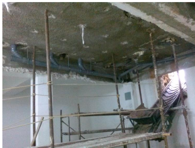
Figura 22 Plataforma de retirada do entulho
