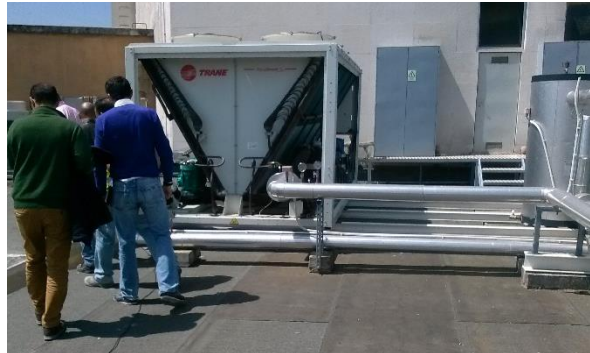
Figura 21 Visita à cobertura da Reitoria da ULisboa
