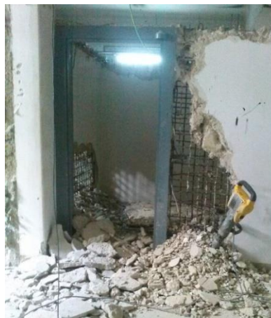
Figura 28 Antigo cofre do Piso -1
